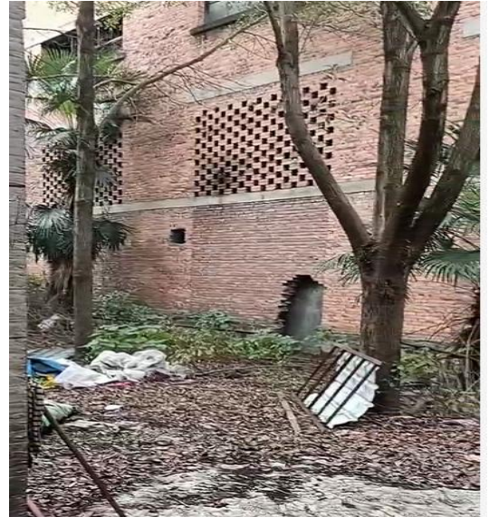
项目厂界西面
