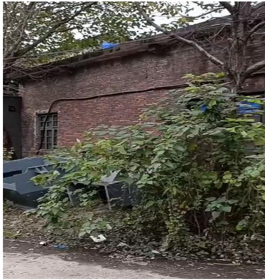
项目厂界北面
