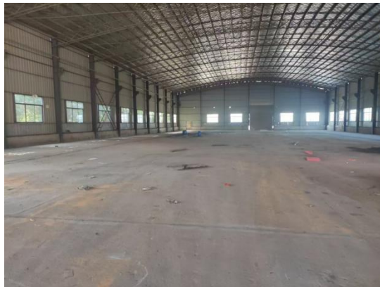
厂区二（破碎区）内部
